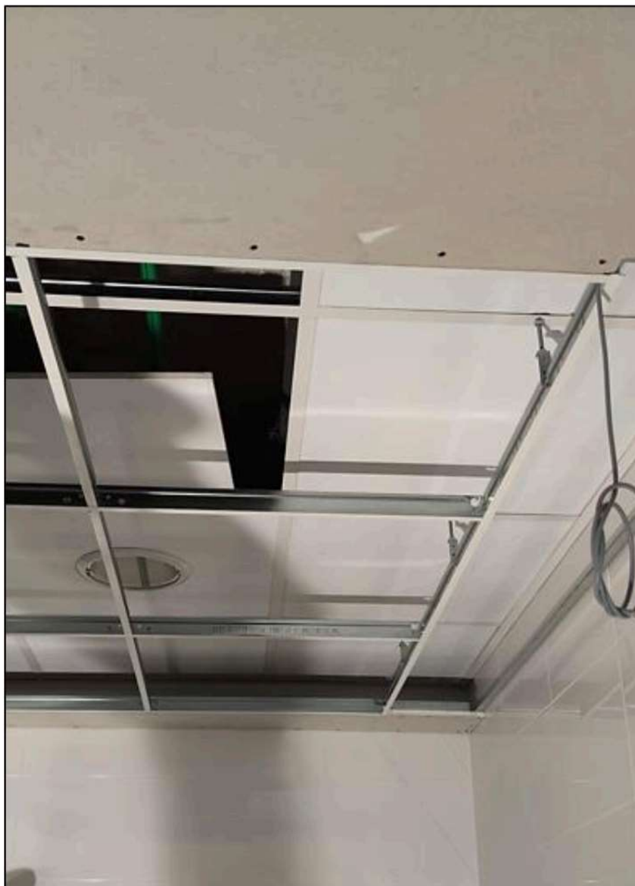
Figura 1. Preparación del falso techo para el montaje de los paneles refrigerantes.
