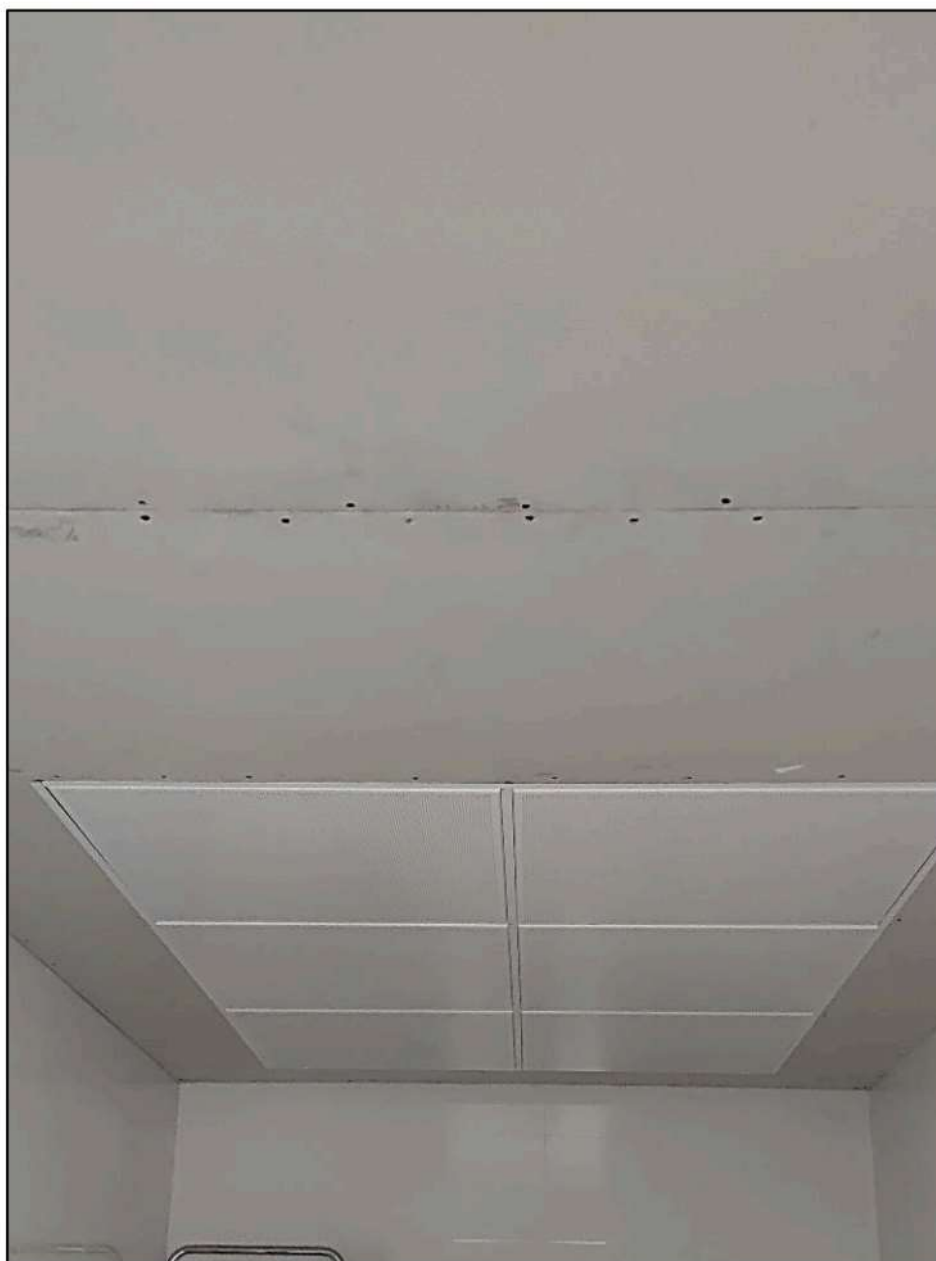
Figura 2. Acabados superficiales de cartón yeso y paneles metálicos micro perforados.
